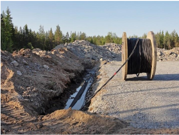
Kuvapari 2.14 Maakaapelit upotetaan huoltoteiden yhteyteen. (Kuvat: Ville Suorsa, FCG)
