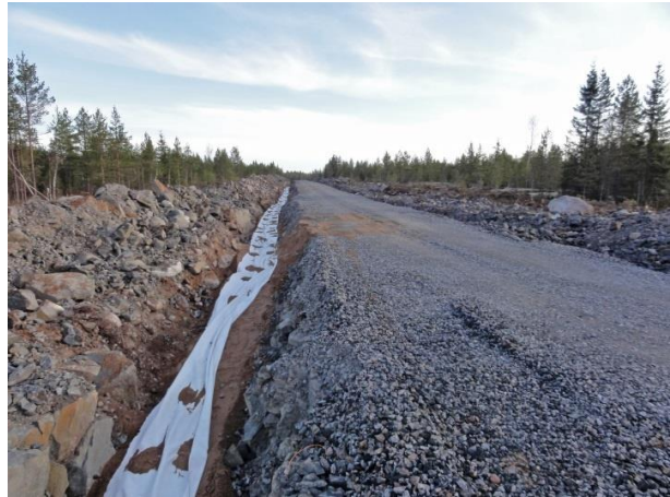
Kuvapari 2.14 Maakaapelit upotetaan huoltoteiden yhteyteen. (Kuvat: Ville Suorsa, FCG)
