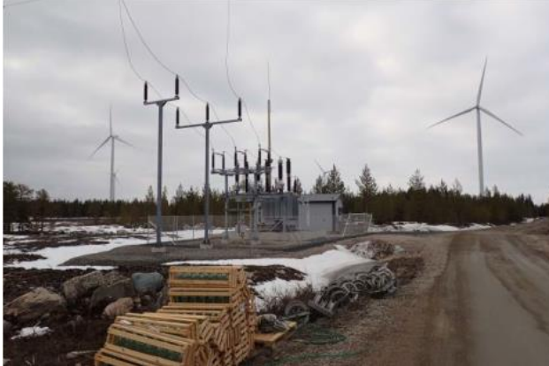
Kuvapari 2.17 Sähköaseman ja voimajohtojen rakentamista. (Kuvat: Ville Suorsa, FCG)
