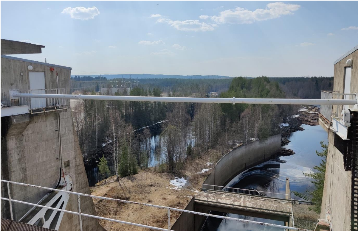
Kuva 5.11 Oulujoen ja Sotkamon reitin voimalaitokset (Seitenoikean voimalaitos). Seitenoikean sähköasema näkyy taka-alalla. (Kuva: Minna Takalo, FCG)
