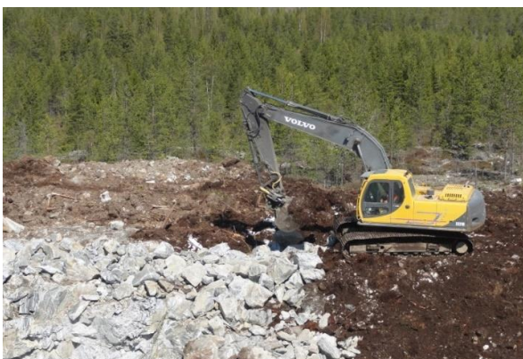
Kuvapari 2.13 Tuulivoimapuiston rakentaminen alkaa huoltoteiden ja pystytysalueiden rakentamisella. (Kuvat: Ville Suorsa, FCG)
