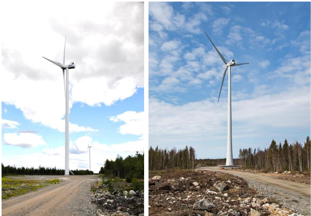
Kuvapari 2.8 Vasemmalla on esimerkki teräslieriötornista ja oikealla hybriditornista. (Kuvat: Leila Väyrynen ja Ville Suorsa, FCG)
