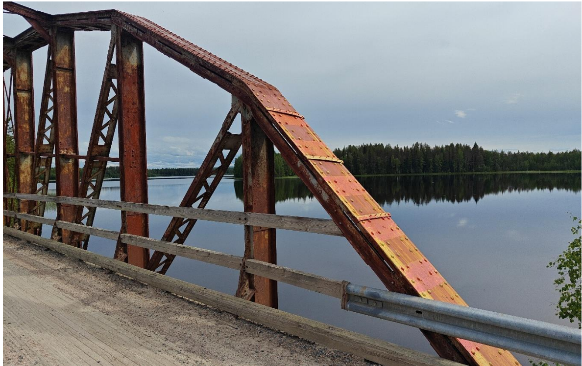
Kuva 75 Vihajärven sillalta Hirvivaara-Murtiovaaran tuulivoimaloiden suuntaan avautuva näkymä. Kuvauspiste E.
