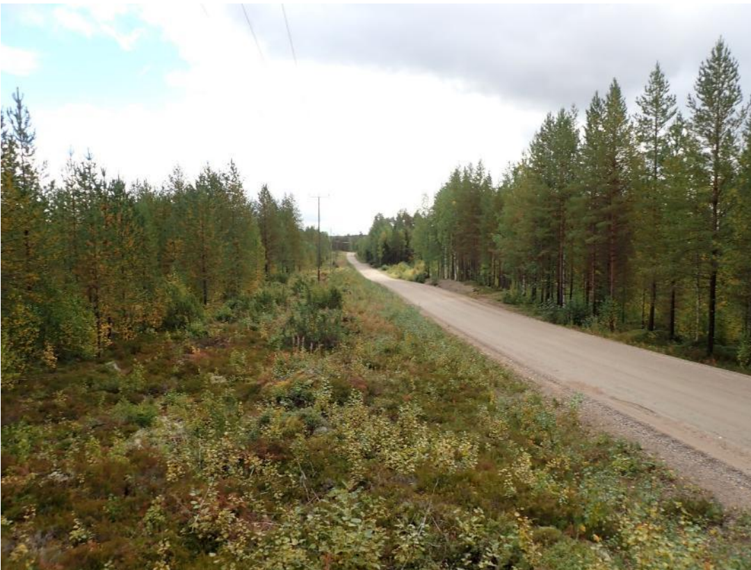
Kuva 2. Yleiskuva maakaapelin 1 loppupäästä Vihajärventien varrella. Kaakkoon.
