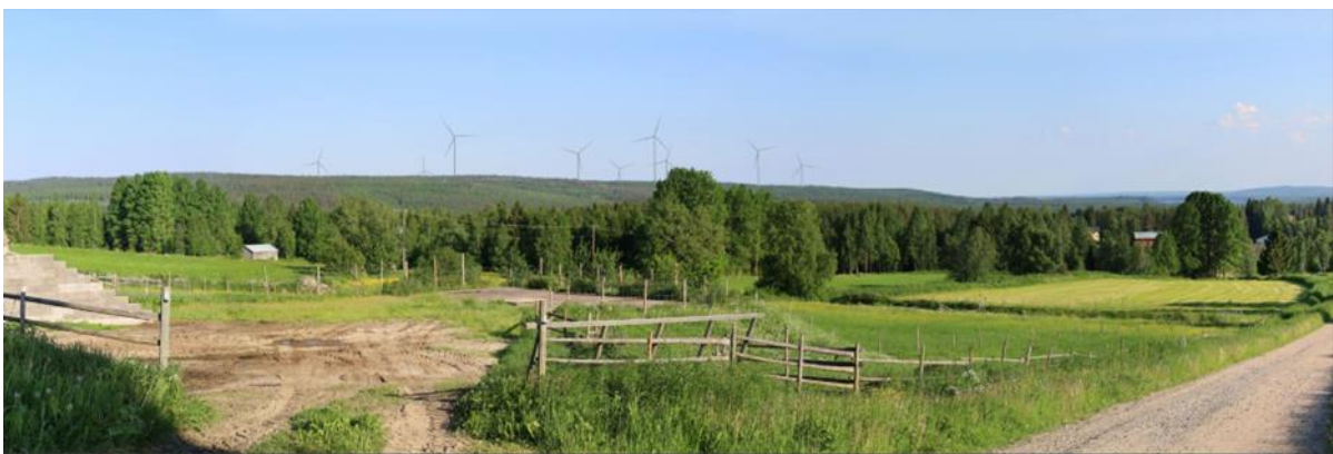
Kuva 9-9. Puolangan ja Ristijärven voimalat Latvan kylästä Mikkolan tilan edustalta katsottuna. Tuulivoimaloiden korkeus 300 m. Etäisyys noin 3 km.
