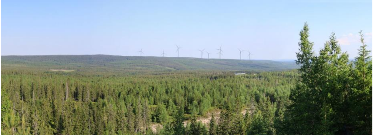
Kuva 9-8. Puolangan ja Ristijärven voimalat Paljakan laskettelukeskuksen huipulta katsottuna. Etäisyys on noin 6 km.
